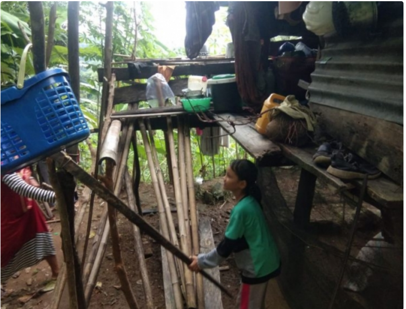
Kondisi Rumah Ibu Muliani Salah Seorang Warga Mattapawalie, Kecamatan Pujananting, Kabupaten Barru
