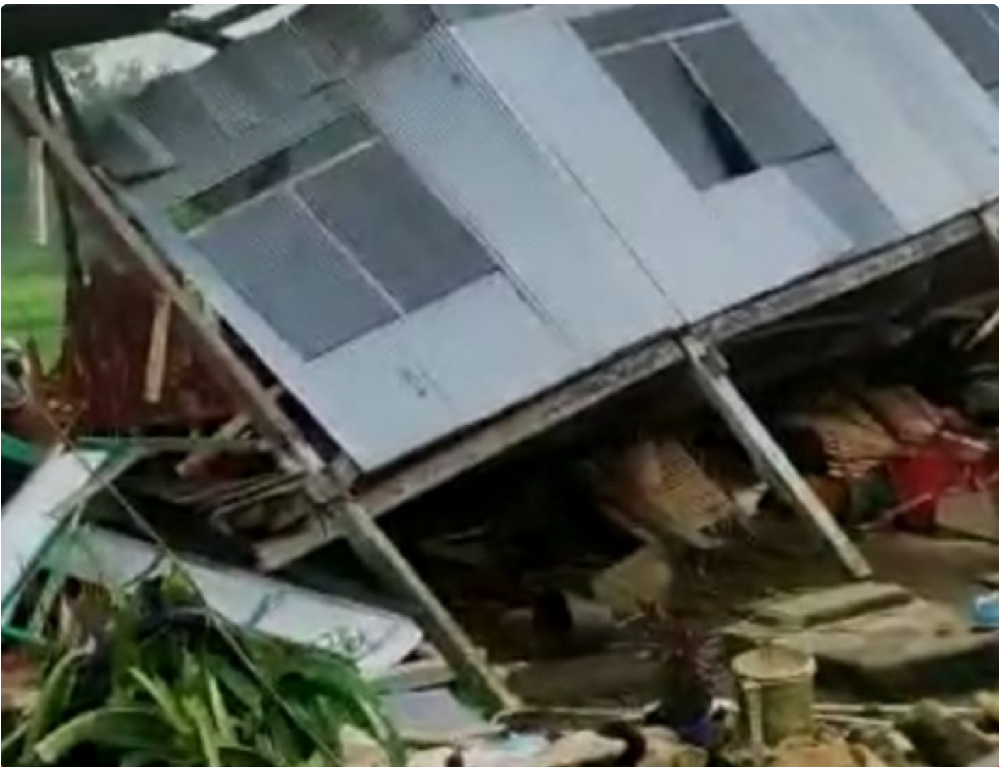
17 rumah rusak parah akibat angin puting beliung di Desa Pancana, Kecamatan Tanete Rilau, kabupaten Barru
